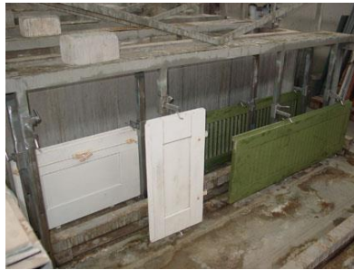
Foto II: Fensterläden vor dem Ablaugen
