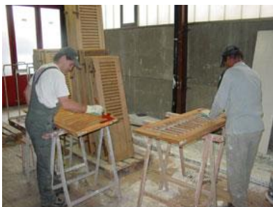
Foto VII: Rostschutz auftragen
